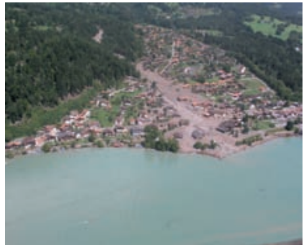
Inondation à Brienz (août 2005). Le centre du village a été emporté par une coulée de boue provoquée par un éboulement dans le canal. Tous les immeubles détruits n'ont pas pu être reconstruits, car le dimensionnement des capacités d'écoulement implique un canal plus large.
