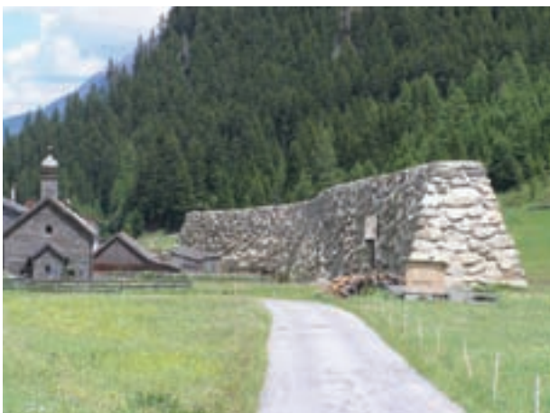
Impressionnant : mur de protection contre les avalanches à Galtür, Paznaun
