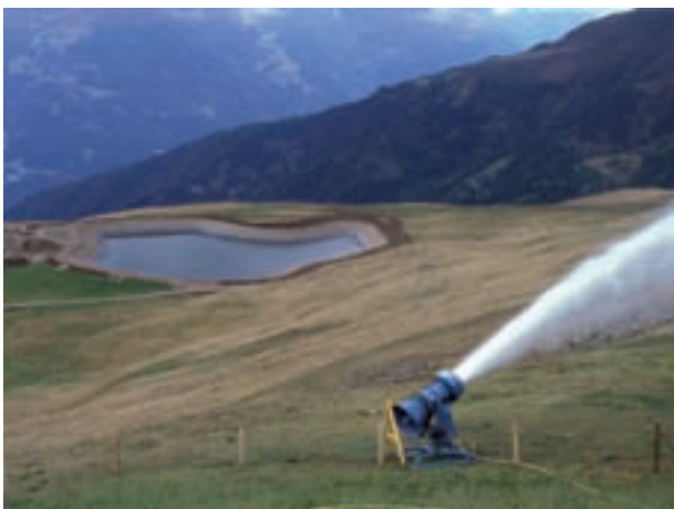
Les canons à neige et les bassins d'eau pour l'enneigement artificiel font désormais partie du paysage des domaines skiables. Leurs coûts de construction et d'entretien sont énormes. Leurs effets sur les espaces naturels ne sont pris en compte qu'à titre accessoire.
