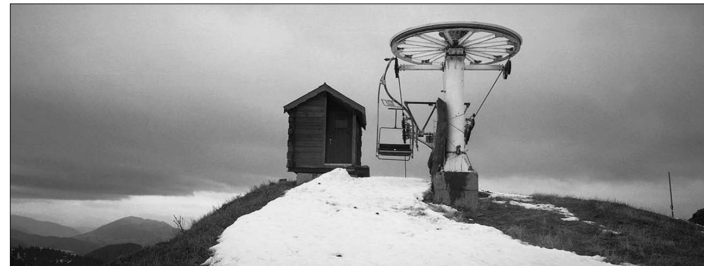
Illustration 2 : Remontée mécanique à Chamrousse (Isère, France) durant l'hiver 2006-2007. Photo : Fred Pontoire.
